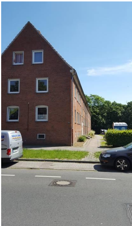
Hermann-Allmers-Straße: 3 geschossige Bebauung / 6 Parteien-Eingänge.
