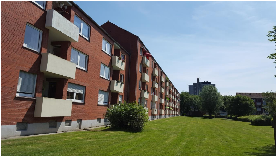
Gustav-Freytag-Straße: 3-4 geschossige Bebauung, 6 Parteien-Eingänge. Im Hintergrund ist 7 geschossige Bebauung zu sehen.
